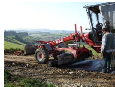
Pose du géotextile
