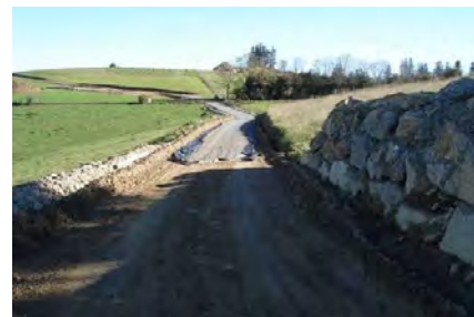
Mise en place du gravier
