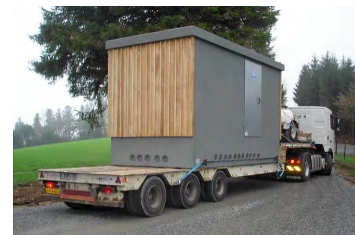
Figure 222 : Arrivée d'un poste de livraison sur un site éolien
