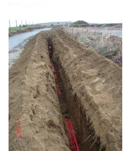
Réalisation de la tranchée et de la pose du câble simultanément
